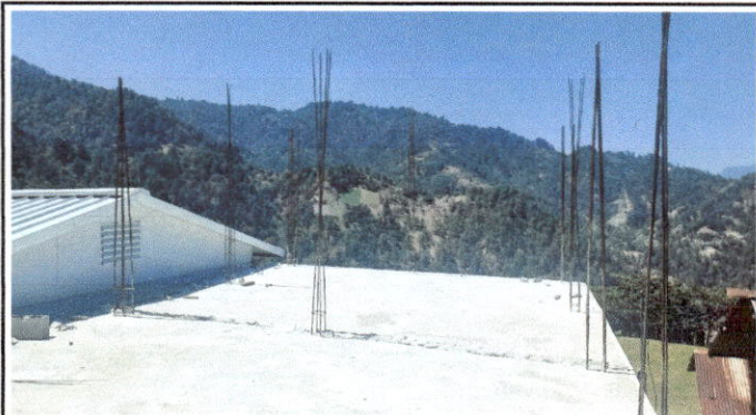
Foto 1. Esta fotografía presenta la terraza del primer nivel del centro educativo, lugar del que se dispone para construcción.
